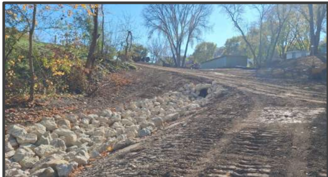
Las alcantarillas, los bordillos y los sumideros de ZRE dirigen las aguas pluviales de forma segura hacia abajo, por debajo de la futura carretera, protegiéndola contra los desprendimientos y la erosión.
