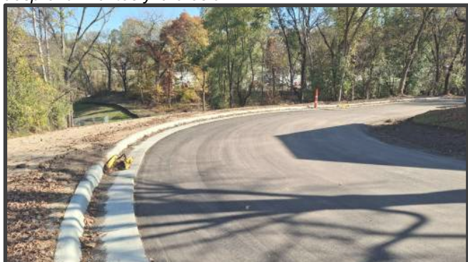
Las alcantarillas, los bordillos y los sumideros de ZRE dirigen las aguas pluviales de forma segura hacia abajo, por debajo de la futura carretera, protegiéndola contra los desprendimientos y la erosión.
