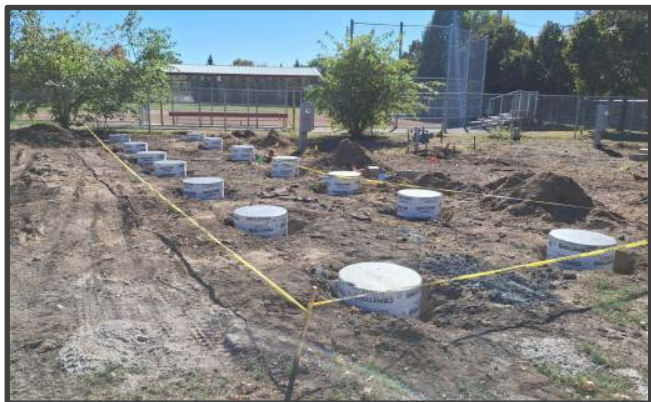
Se colocan pilares de hormigón en terrenos baldíos como preparación para una nueva vivienda de una sola sección para WTC.
