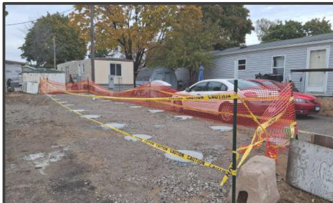
Abajo: Terreno baldío preparado con pilares de hormigón para la construcción de una nueva vivienda de una sola sección en PPC.
